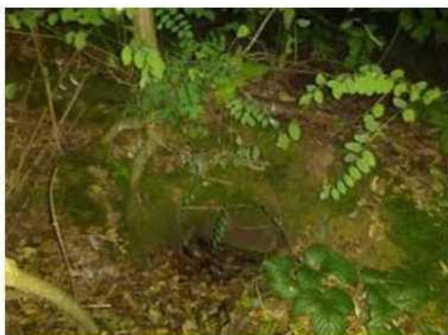
kameni blok od ostatka tunela
